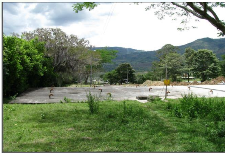
Imagen No. 6 Tanque de almacenamiento1
