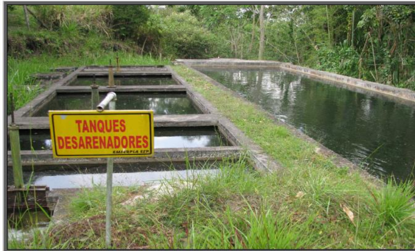
Imagen No. 3 Tanque desarenador
