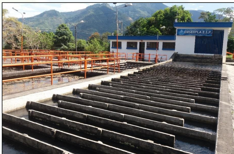
Imagen No. 4 Floculadores
