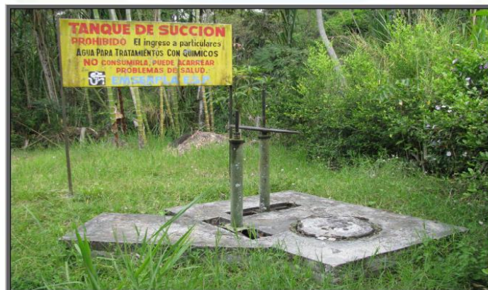
Imagen No. 2 Tanque de succión
