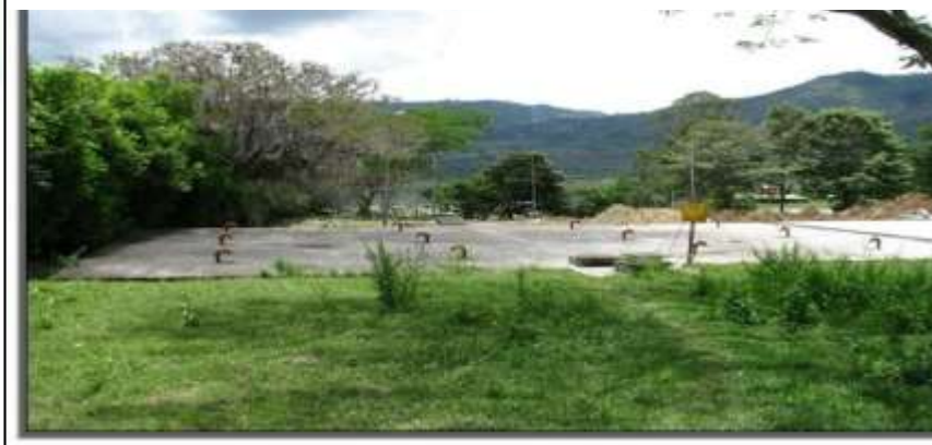
Figura 11 .Tanque almacenamiento # 1 (antiguo)
