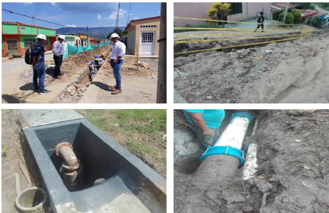
Proyecto que contempla la reposición de redes de acueducto y alcantarillado para el sector de san Rafael, debido al mal estado de las redes y para cambio de material ya que se encuentra en asbesto, adicionalmente se realizó un mantenimiento en la planta de tratamiento con el fin de optimizar las redes de aducción, la funcionalidad del desarenador, entre otros aspectos importantes que beneficiaron a la comunidad del Municipio de La Plata.
