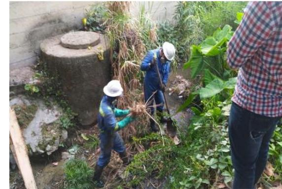
Esta actividad se realiza debido a los diferentes taponamientos en las redes y en los pozos de alcantarillado lo que obliga a realizar un sondeo interno con el fin de rehabilitar las redes y realizar el respectivo mantenimiento. Se beneficiaron los siguientes sectores: El Pomo, Páez, estancia, García herreros, Eudes, Canadá, san Isidro, Rafael Ramírez Otálora.
